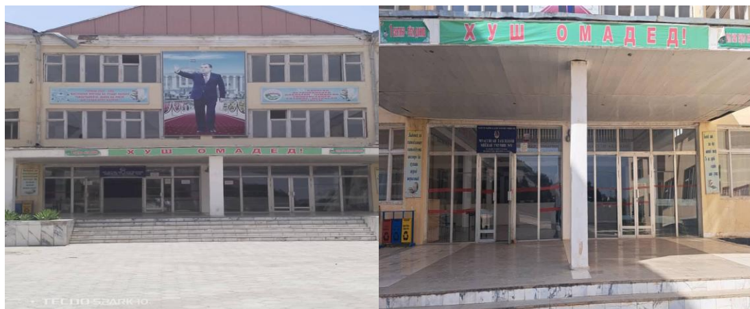
Рис.3. Центральный вход в школу №51, г.Куляб
