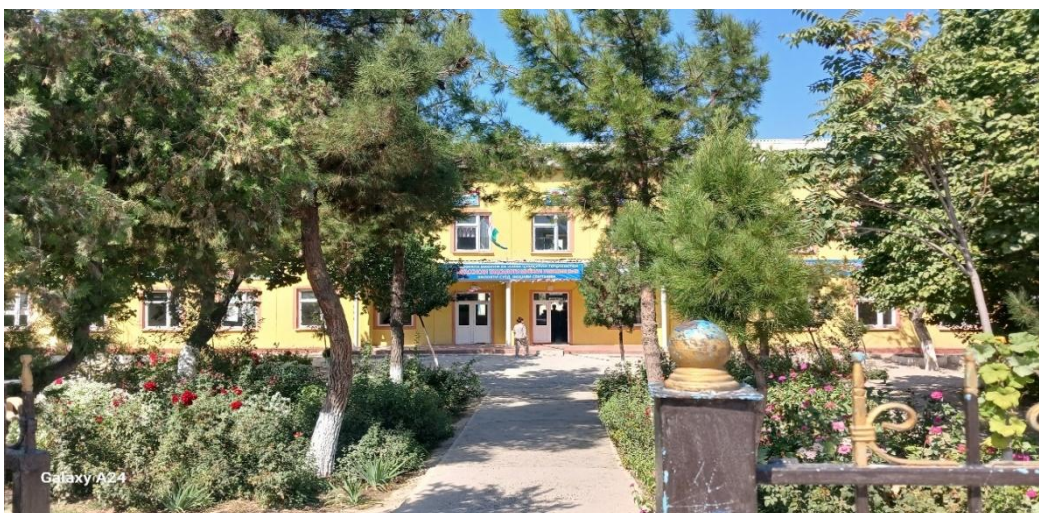
Рис 2. Главный вход в школу
