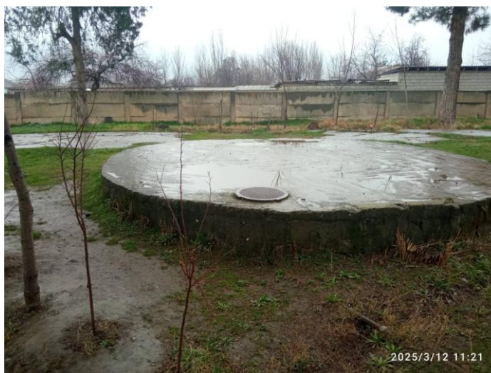
Противопожарный щит и противопожарный колодец.
